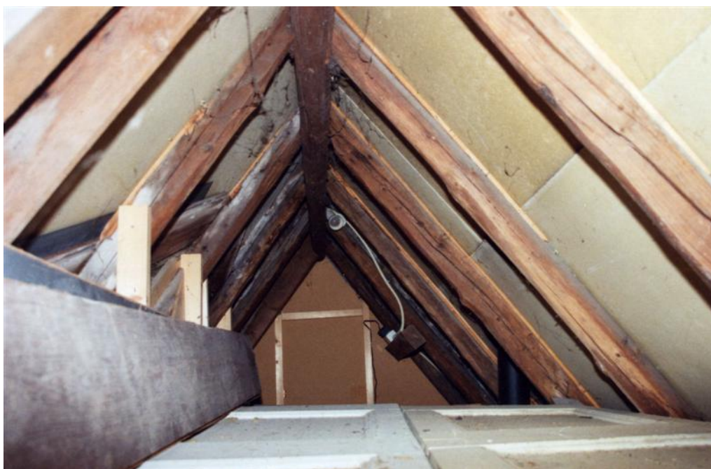
De kapconstructie boven het niveau van de vloering.
